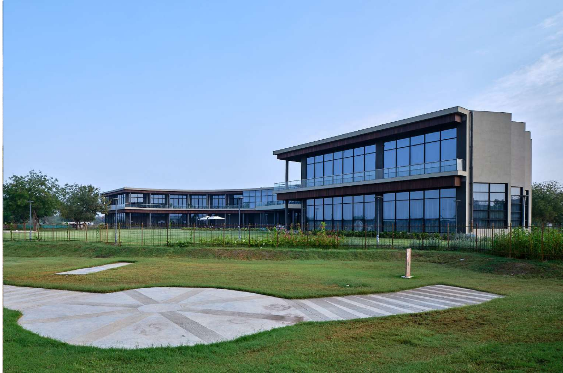
Actual Site Image
